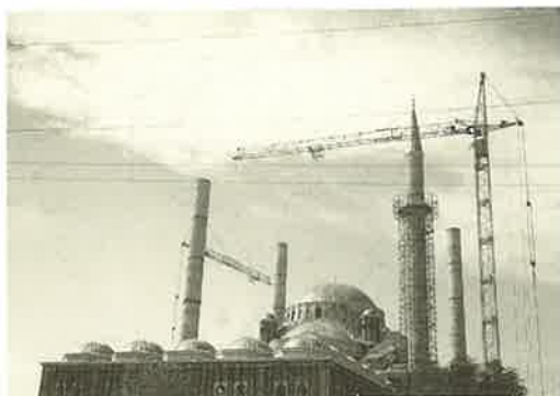
図6 アシガバト都心の大モスク建設現場
