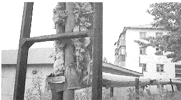
写真—6 テルマル・集団農場の温水パイプ Photo 6 On Warm Water Pipe of Termaru Sovkhoz.
