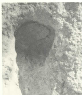
④天井の剥落と岩粉生産
