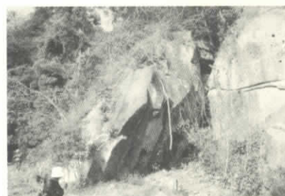
④崩落した巨大なスラブ（岩塊）
