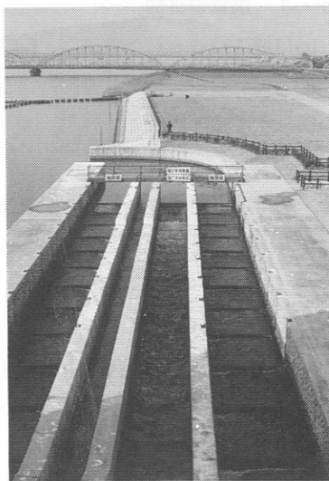
左岸呼び水魚道 階段式魚道
