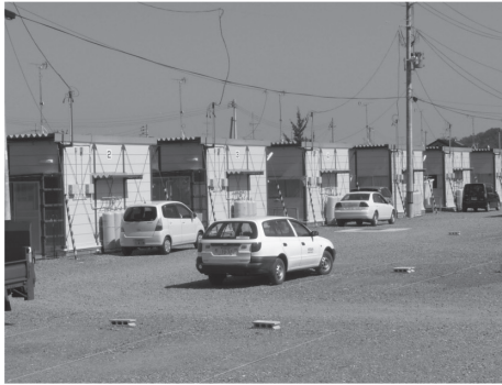
好間地区の仮設住宅
